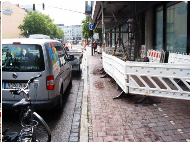
je nach Arbeitsablauf werden die Baustelle vergrößert
