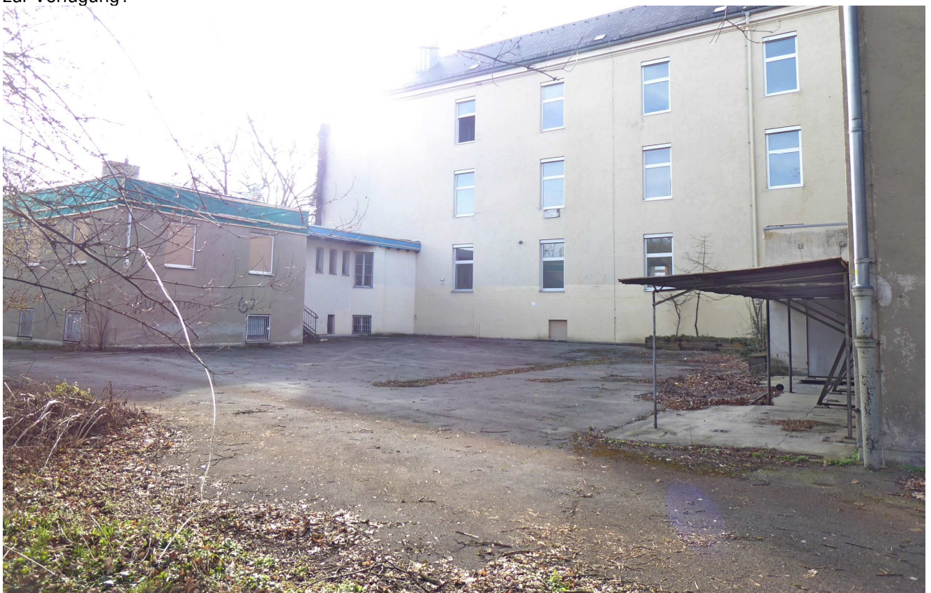
Schulhof im Norden – an jeder Stelle geeignet für den Leiterwagen der Feuerwehr. Aber nicht für einen Bagger?
