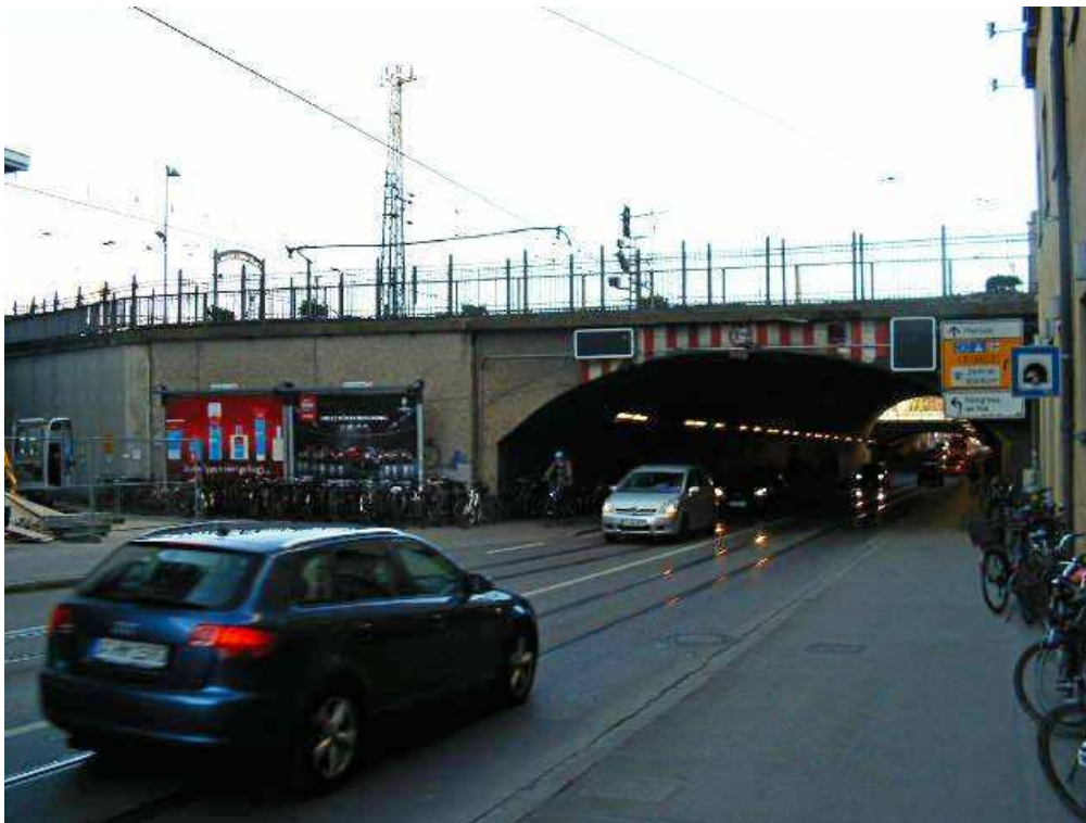
ungesicherte Ausfahrt Radparkhaus nach Westen
